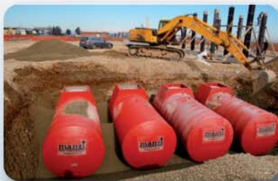
Installazione di serbatoi da 50mc Installation of 50m3 PetrolTank
